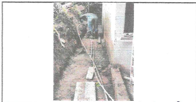
Foto 5: Colocacion de la tuberia en la parte del suelo.
